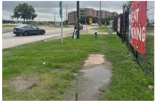
Varias aceras en el área del proyecto son impasables, como esta en la calle Hutchins en el este del centro de Houston.
